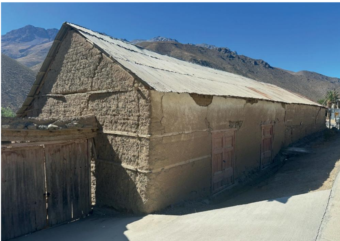
Figura 92. Casa de tierra cruda (adobe), con encintados de madera. Entrada a Tulahuén. Foto: Juan Blázquez
