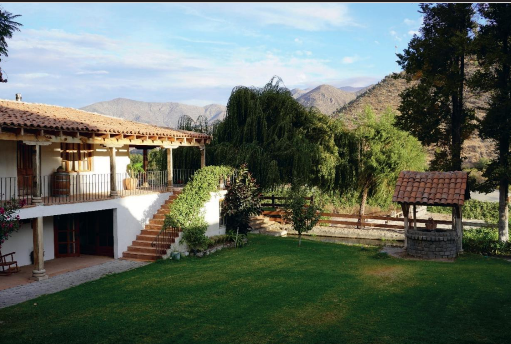
Figura 94. Patio interno de la Hacienda Juntas. Foto: Alexandra Kann
