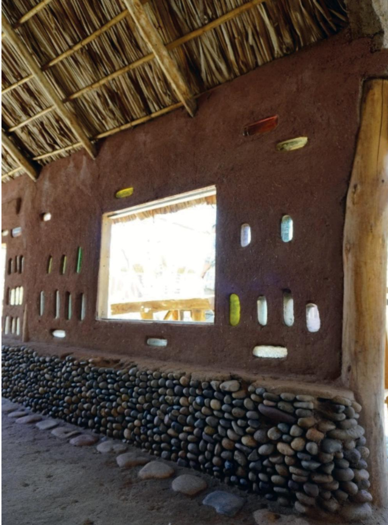
Figura 46. Muro del restorán Cabildo Abierto, con cimientó de piedra, muro de tierra cruda y techo de totora. Foto: Alexandra Kann
